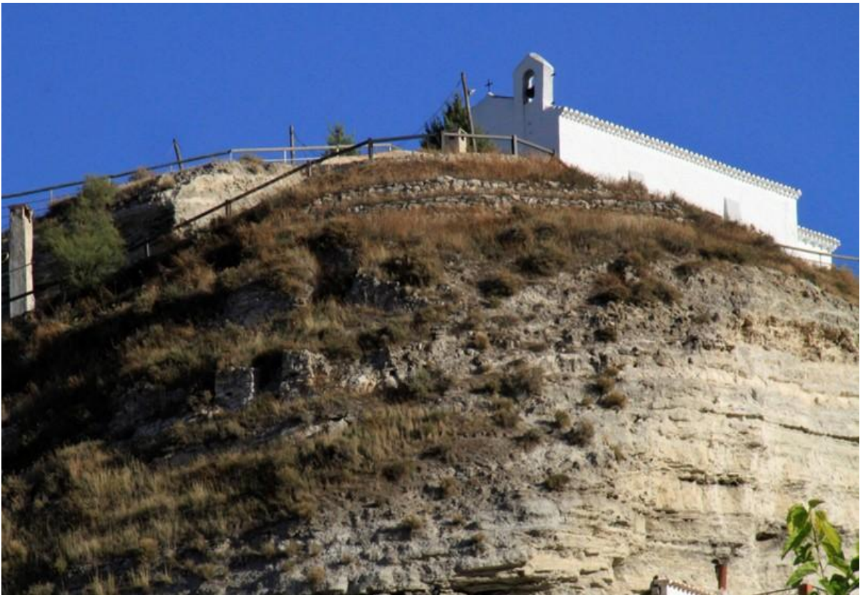
Posibles restos del segundo cinturón de muralla, a media altura de la ladera O, en la zona S del cerro. Se aprecian también otras cintas de mampostería que perimetran la parte superior. (Imagen del autor).
